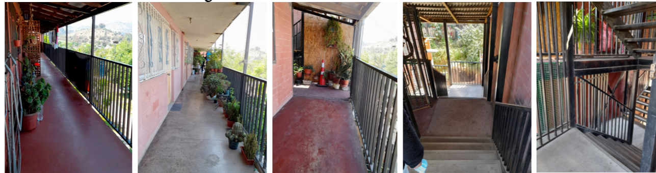
Figura 11: Interior condominios de vivienda.
