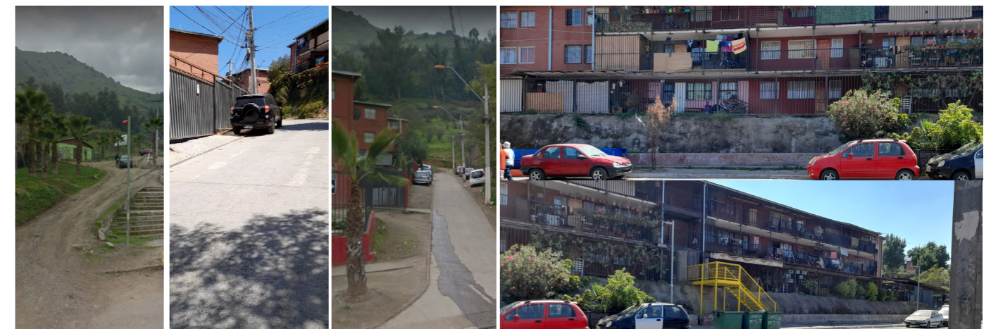
Figura 3: Condición de pendiente conjunto Las Canteras.
