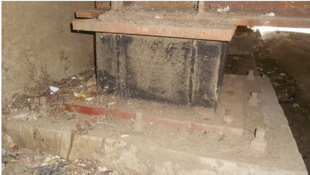
Figura 2.9: Aislador elastomérico en estribo sur.
