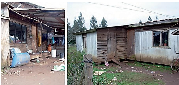
FIGURA N°23: Foto izquierda: frente ingreso. Foto derecha: exterior bodega y salida desde estar. Fuente: autoría propia.
