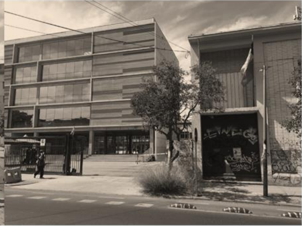
Figura: Fachada Norte F. Qca y Farmacia UCH. Fuente: propia (30 noviembre, 2021)
