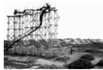
16. Torres de agua Ciudad Abierta
