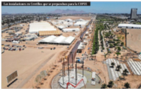
Las instalaciones en Cerroillos que se prepararon para la COP25.
