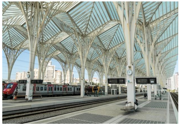
Imagen 38: Estación de Oriente / Santiago Calatrava / Portugal
