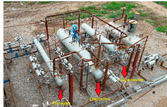
(b) Sistema de generación de vapor.
