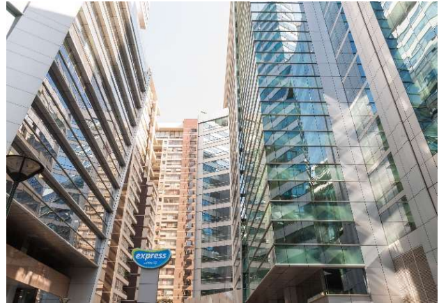
Ilustración 18: Edificio Santiago Downtown.
