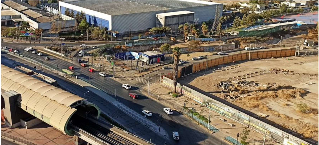
Ilustración 5: Vista aérea desde el oriente del terreno. Fuente: Elaboración propia
