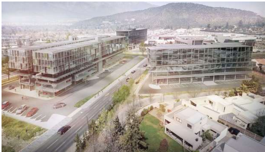
Ilustración 15: Núcleo Los Trapenses. Fuente: (Sabbagh Arquitectos, 2017)
