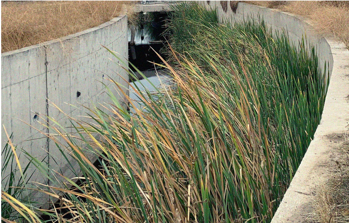
FIG. 33: CANALIZACIÓN DEL ESTERO LAS CRUCES. FUENTE: ARCHIVO PERSONAL, 2023.
