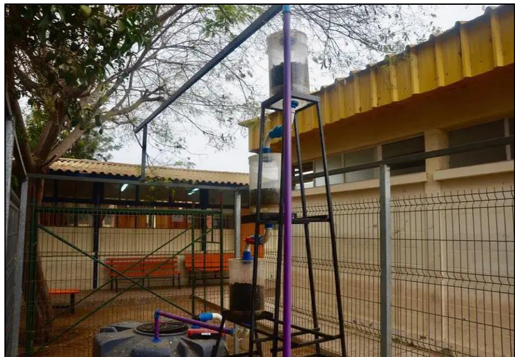
Sistema de reutilización de aguas grises en los colegios | Crédito: La Tercera
