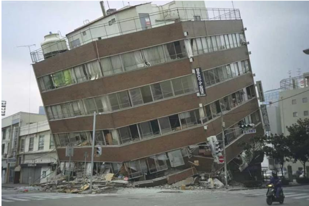
Figura 2.6 Colapso del primer piso en edificio, Kobe 1995, fotografía de NOAA/NGDC Dr. Roger Hutchison (Mustain 2012).
