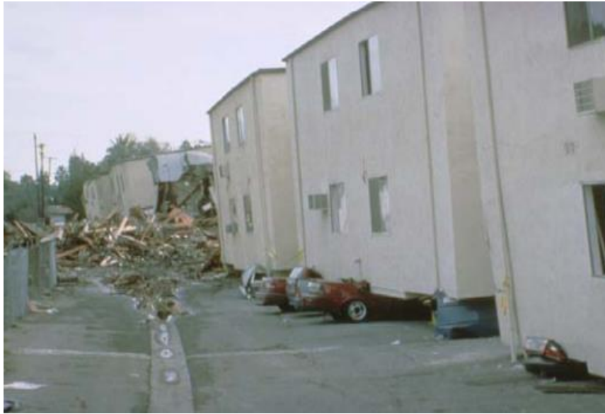
Figura 2.4 Colapso de edificaciones en su primer piso, terremoto de Northridge 1994 (Astroza 2007).
