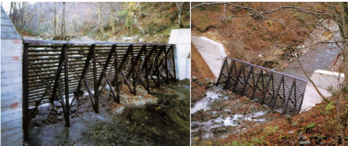
Fig. 2.16 Presa de apertura horizontal ( beam-dam ) (Mizuyama, 2003).
