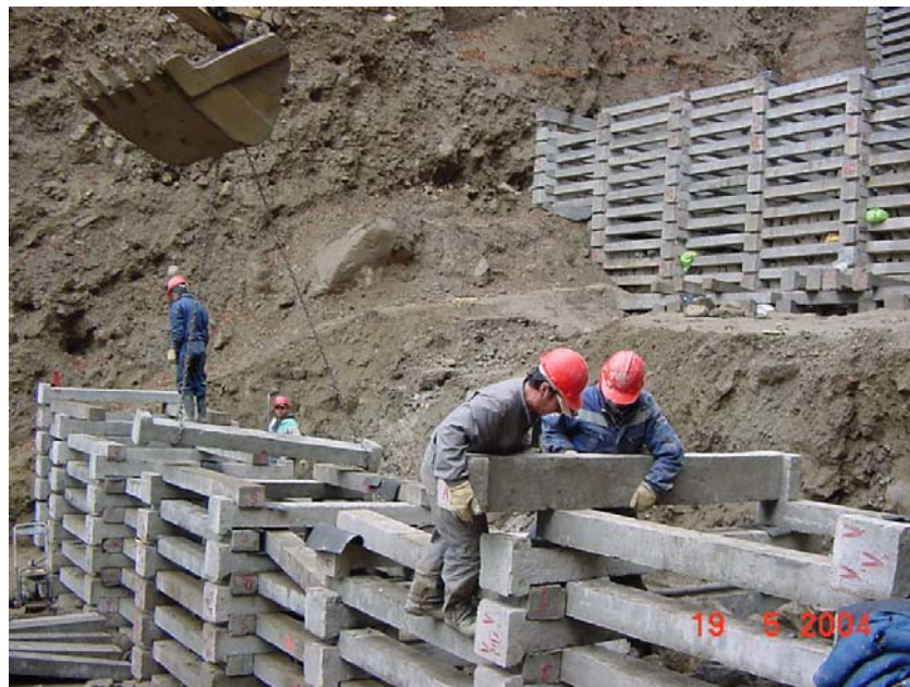
Fig. 3.10 Barrera de viguetas en construcción en la quebrada Mackay (Fuente: Dirección de Obras Hidráulicas, Ministerio de Obras Públicas).
