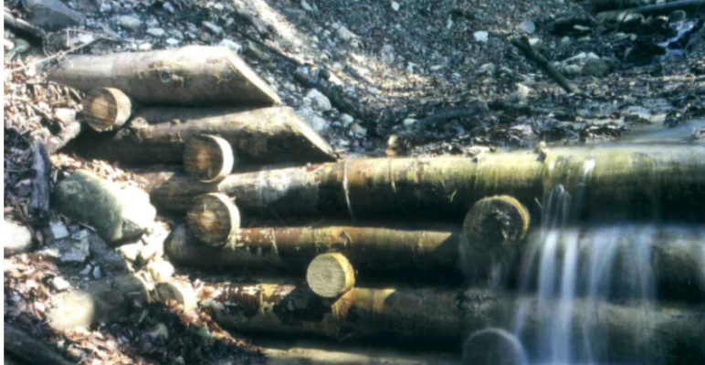
Fig. 2.22 Estructura construida en madera (Fiebiger, 2003)
