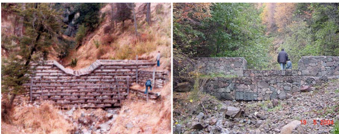
Fig. 3.4 Estructuras de control aluvional (“quincho”) construidos en quebradas ubicadas en la parte alta de la ciudad de Coihaique, XI Región (Hauser, 2004).
