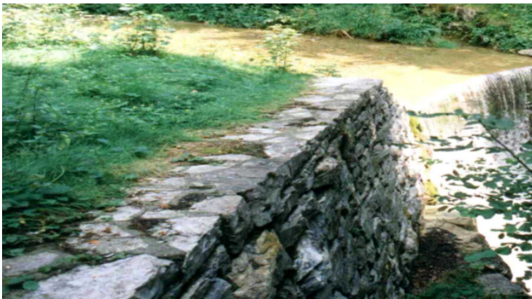
Fig. 2.23 Estructura construida en mampostería de piedra (Fiebiger, 2003)
