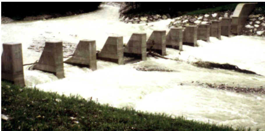
Fig. 2.20 Obra de hormigón diseñada para la captura de material vegetal (Fiebiger, 2003).
