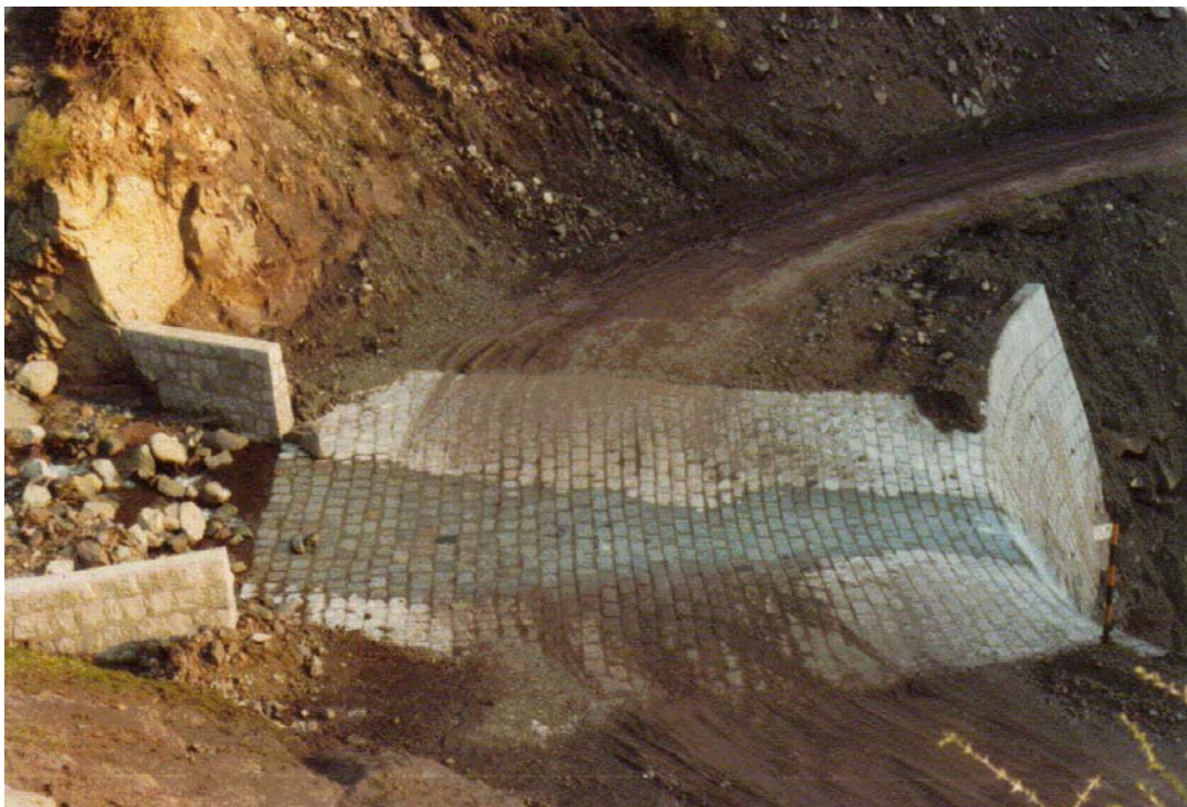
Fig. 3.3 Badén de mampostería destinado a proteger una obra vial en el sector de El Alfafal, Región Metropolitana (Hauser, 2004).
