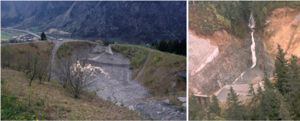
Fig. 2.31 Obras de depositación ( www.mala.bc.ca/~earles/howesound )
