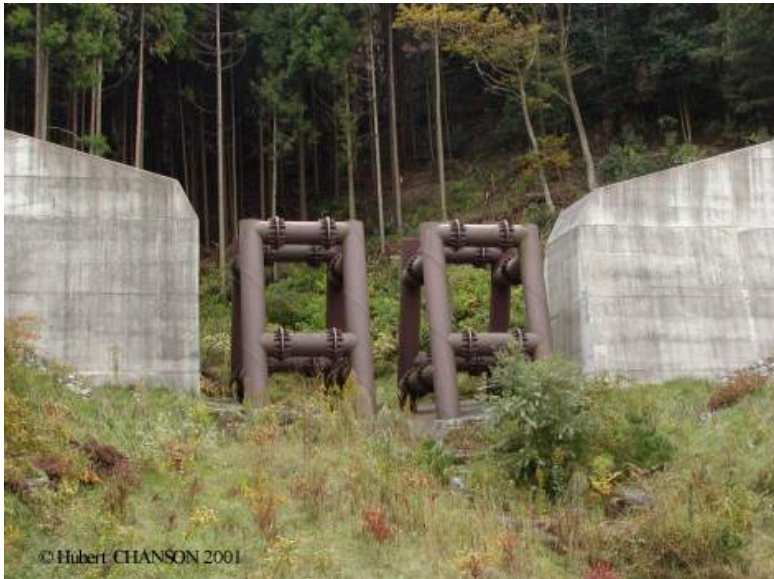
Fig. 2.25 Estructura construida en hormigón y tuberías de acero (Chanson, 2001).
