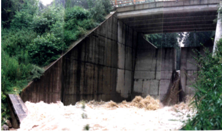
Fig. 2.24 Estructura de hormigón (Fiebiger, 2003).
