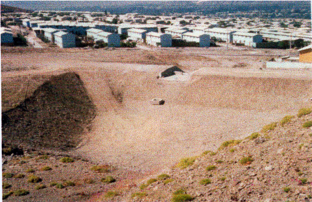
Fig. 3.7 Tranques almacenadores construidos en la ciudad de Copiapó (Hauser, 2004).
