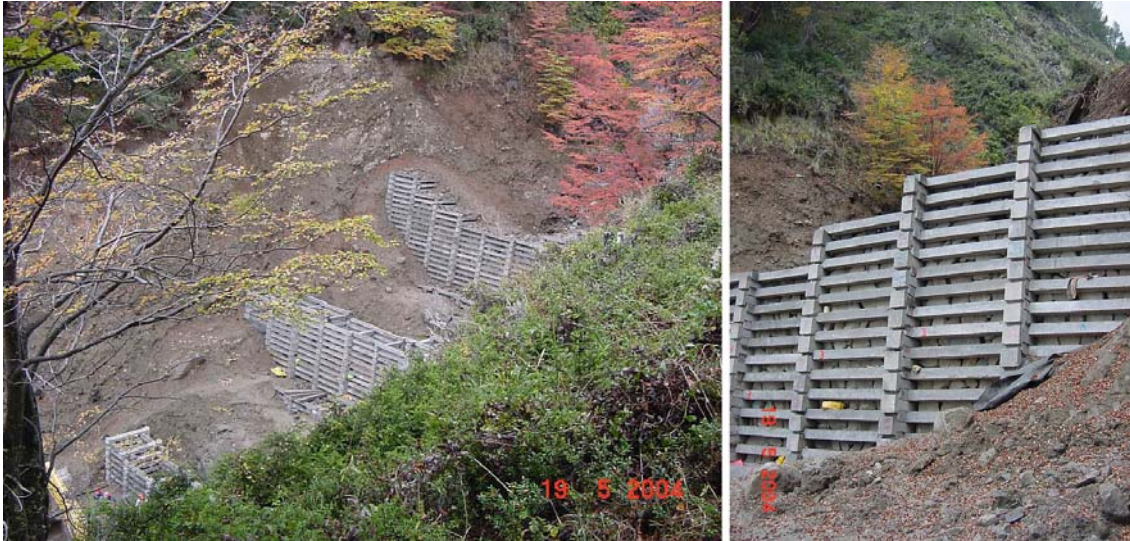
Fig. 3.9 Barrera de viguetas construidas en la quebrada Mackay (Fuente: Dirección de Obras Hidráulicas, Ministerio de Obras Públicas).
