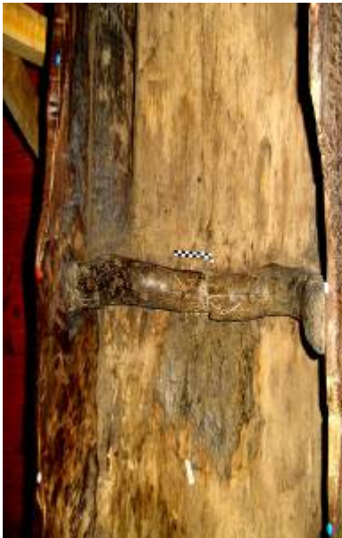
4.- Detalle de la tercera cuaderna la cual es doble, es decir se encuentra sobre las dos bandas.
