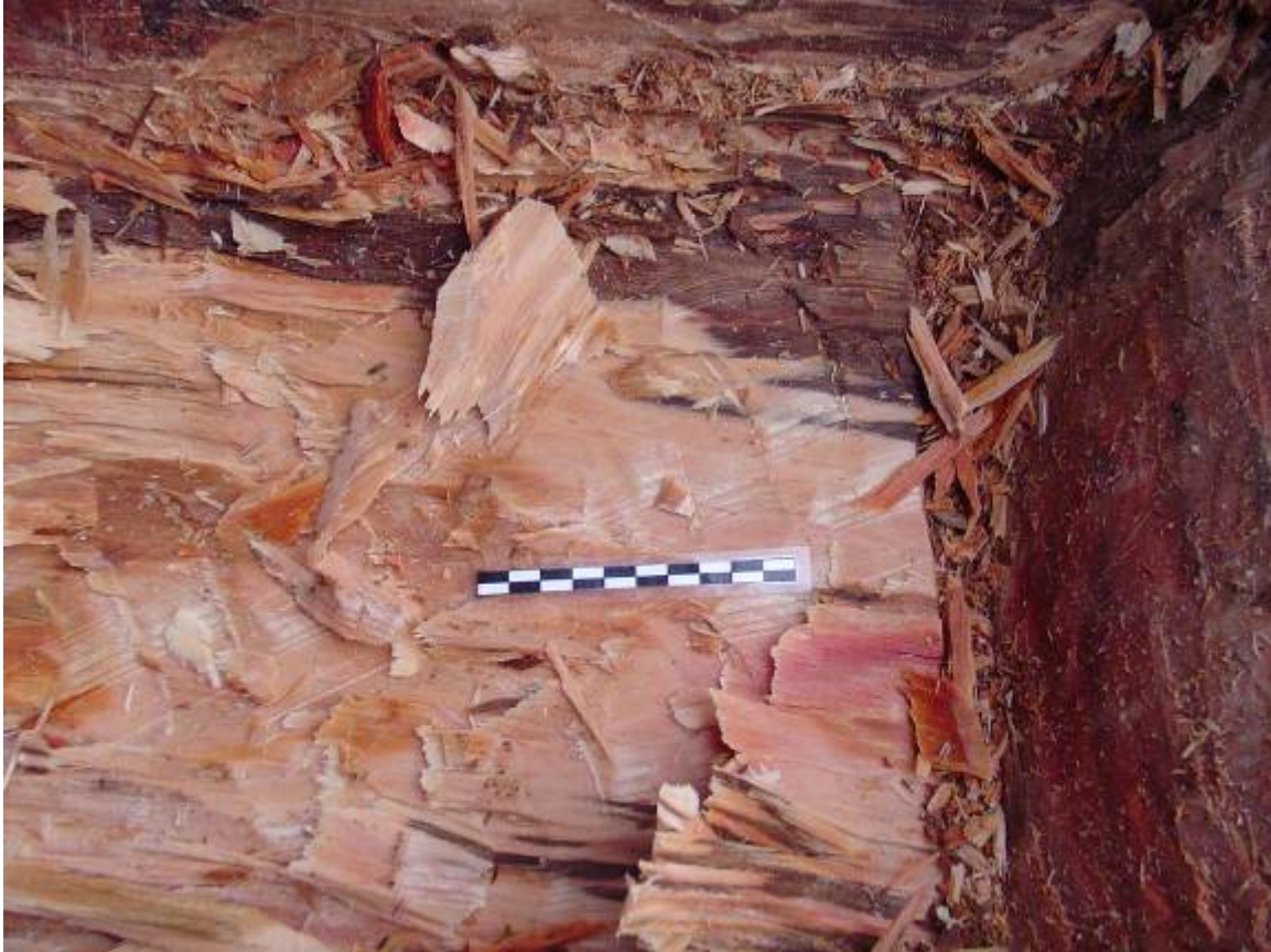
Figura 10. Detalle de las huellas que deja la azuela sobre la madera. Son muy diferentes a las del hacha, ya que el filo de la herramienta levanta la madera en la zona en que se introduce para luego arrancarla por la fuerza que ejerce, rasgándose. La marca del corte es pequeña como consecuencia, pero es evidente el rasgamiento que se produce.
