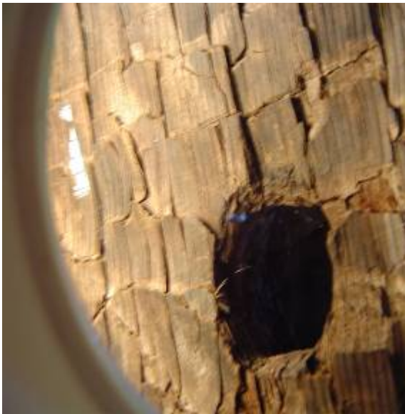
3.-Detalle de uno de los agujeros en que se aprecia la desfoliación de a superficie.
