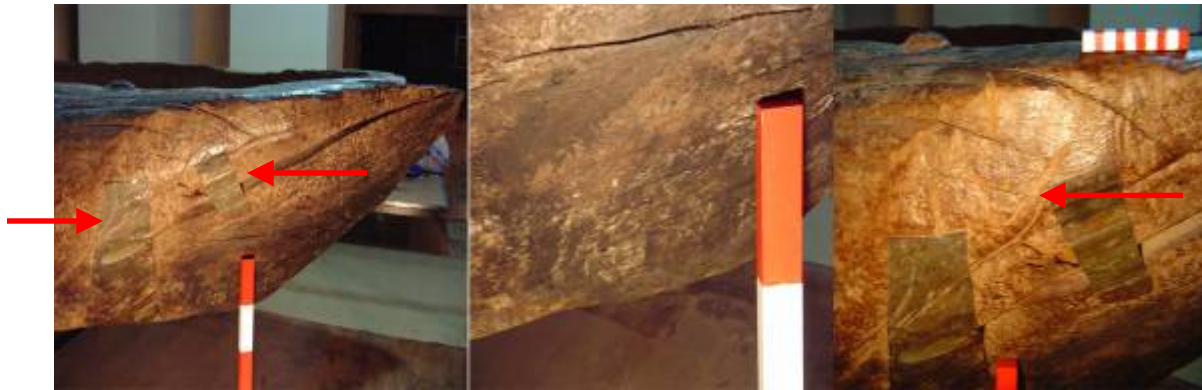
1.-Reparación de rajadura con planchas metálicas.
