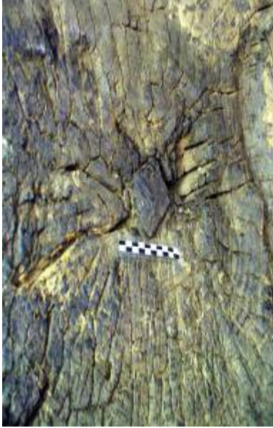
1.- Madero que se aprecia desde el interior en la zona de la proa y que es parte de la reparación exterior de proa.
