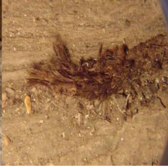
2.-Detalle de la reparación de la rajadura con fibra vegetal preparada.
