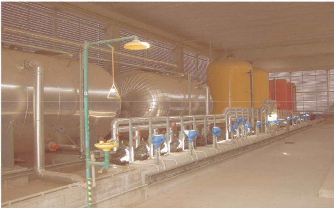
Esta segunda foto muestra donde se realiza la filtración del agua marina para la eliminación de los sólidos en suspensión.
