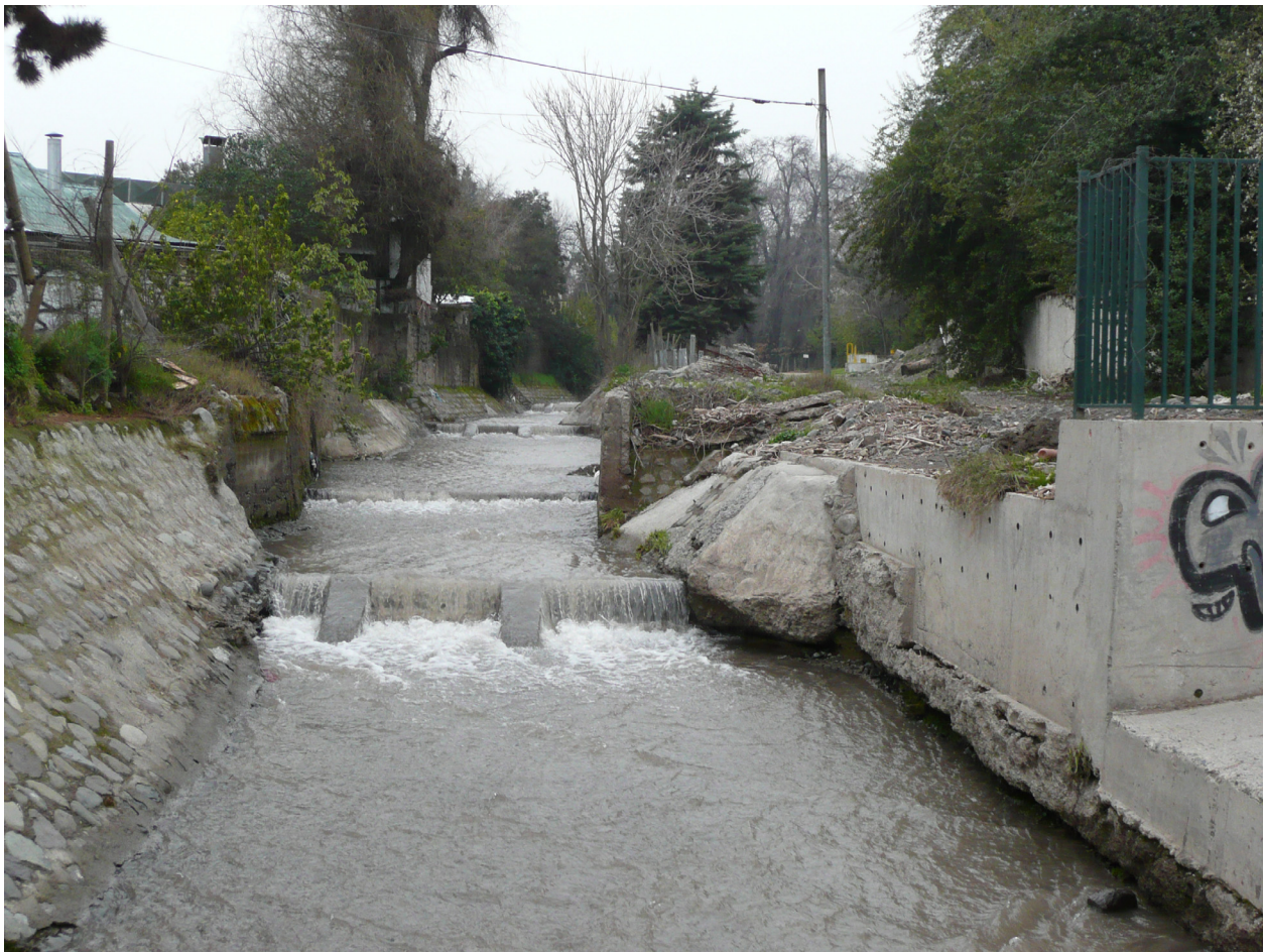
Entrada a alcantarilla, mirando hacia aguas arriba
