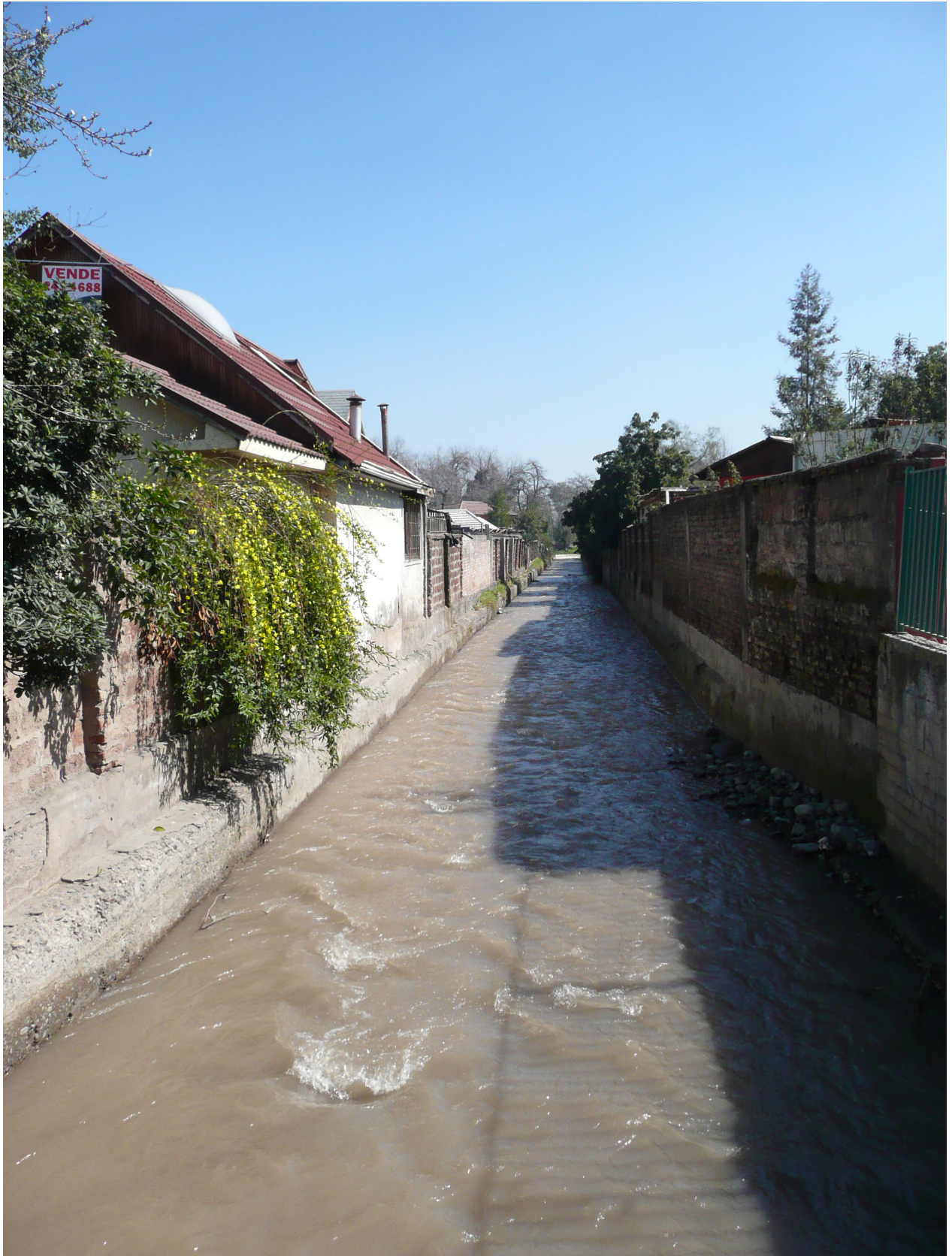
Mirando hacia aguas abajo
