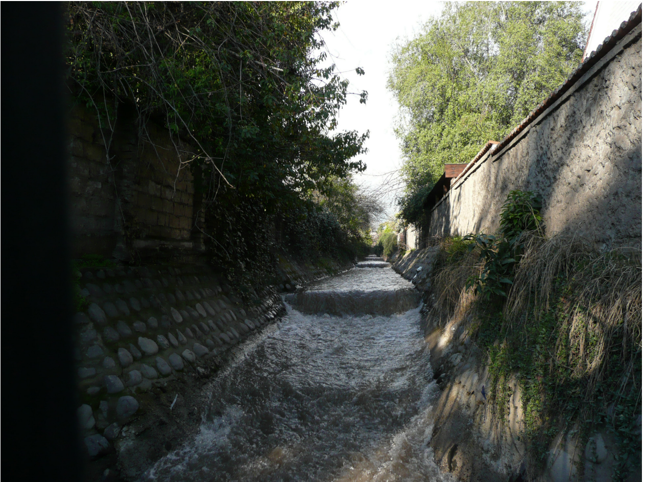
Mirando hacia aguas abajo
