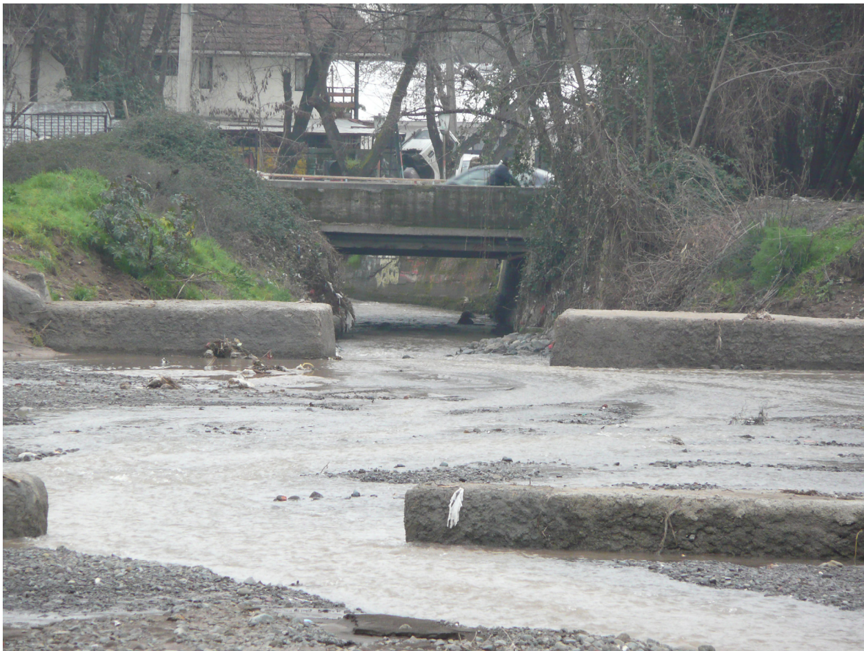
Mirando hacia aguas abajo
