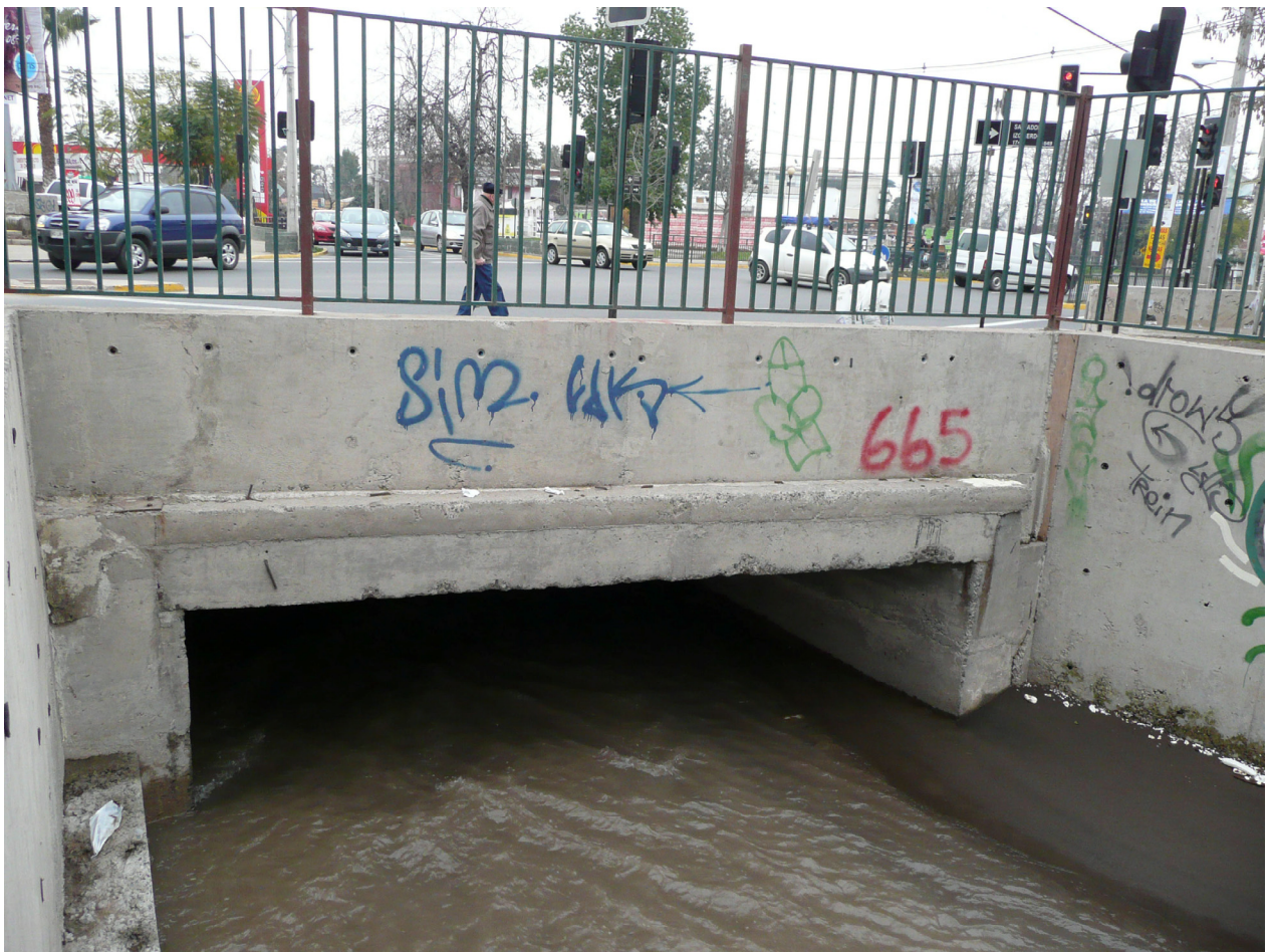
Entrada, mirando hacia aguas abajo
