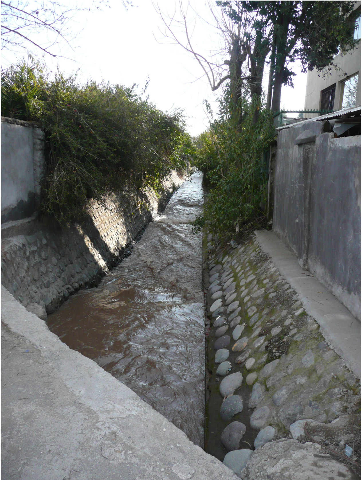
Mirando hacia aguas abajo
