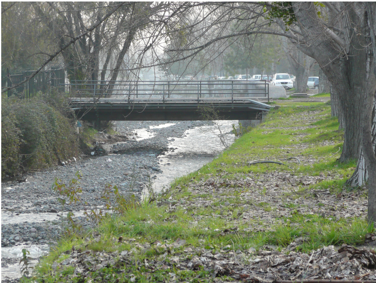
Mirando hacia aguas abajo
