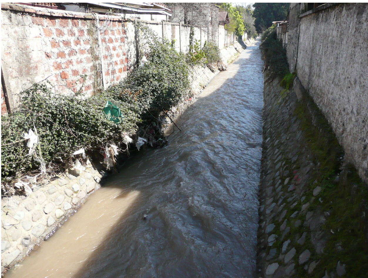
Mirando hacia aguas abajo
