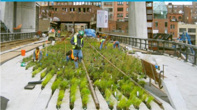
Figura 76: construcción del proyecto, instalación de la capa vegetal.
