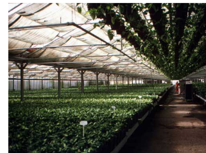
Imágen 26: Invernadero New México. Temperado y regado con uso de bombas de calor
