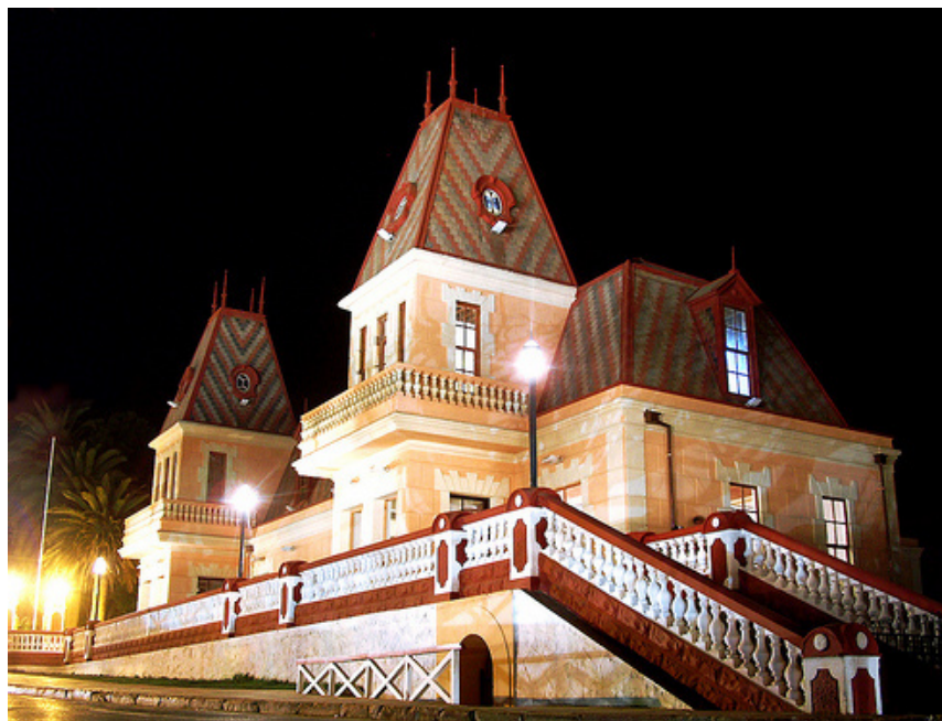
Figura 11: Ex casino Ross, remodelado en el año 2007. (Fuente: www.pichilemu.cl)
