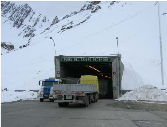
Entrada al túnel
