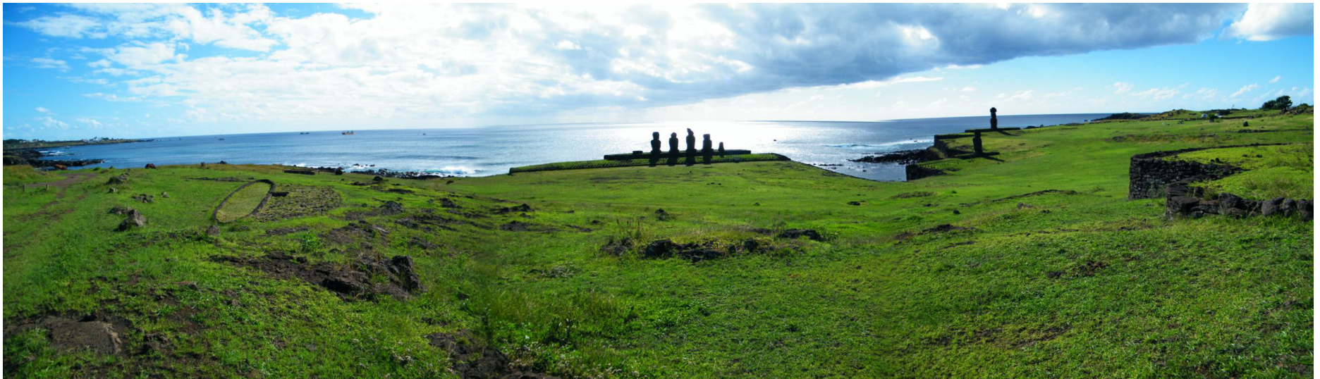
Fig. 52: Complejo Tahai, explanadas y relaciones visuales entre los distintos elementos y el mar.
