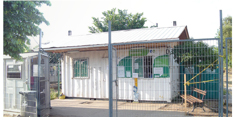
Módulo blindado que sirve como boletería/ imagen propia
