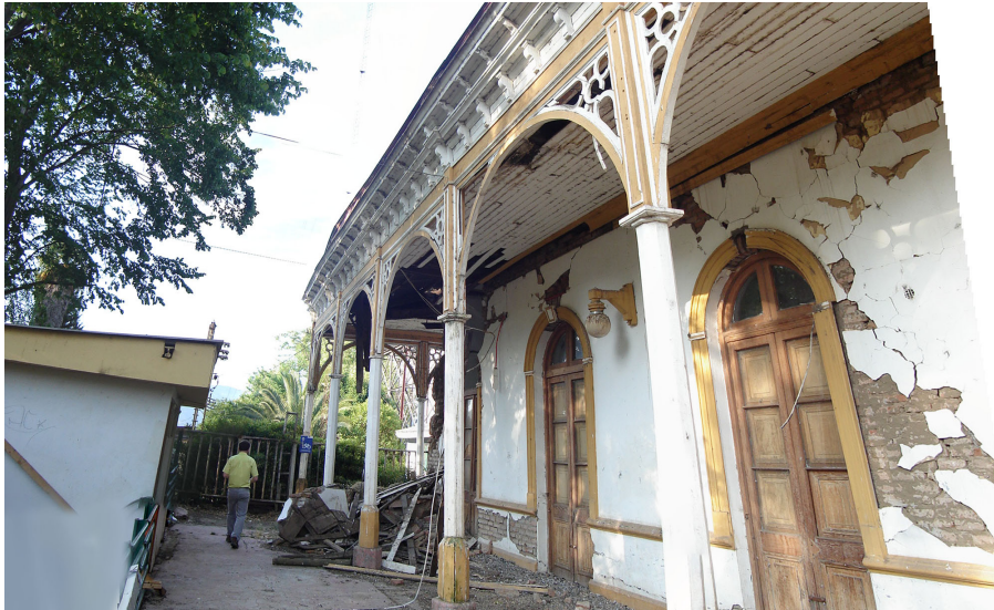
Fachada poniente/ imagen propia
