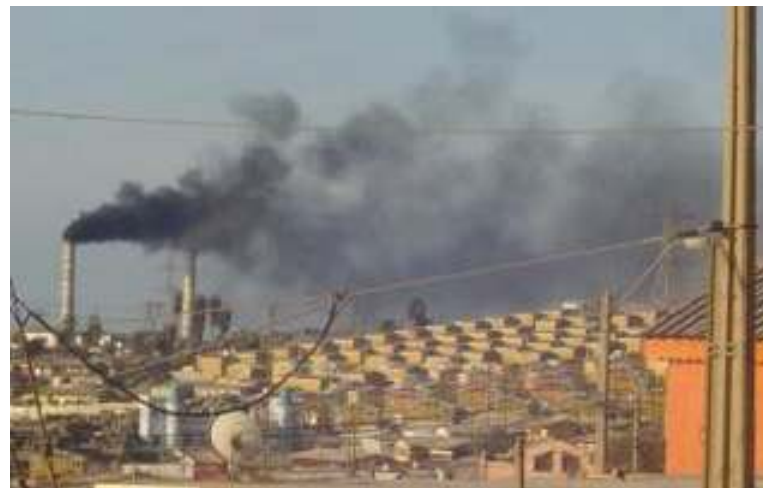
Chimeneas termoeléctrica Norgener
