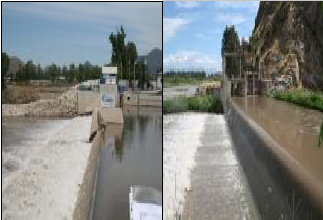
Foto N° 10: Bocatomas de Canales de Regadío
