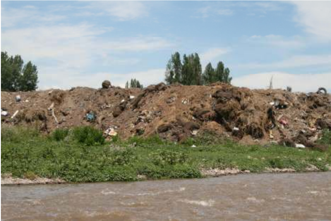
Foto N° 2: Basural que rellena talud de Cono Aluvial
