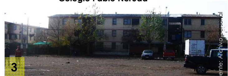
3 Bloques de vivienda 3 pisos
