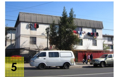
5 Bloques de vivienda 3 pisos
