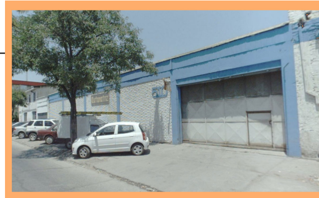
Imagen 22: Elaboración propia. Fotografías de la situación actual de la manzana.
