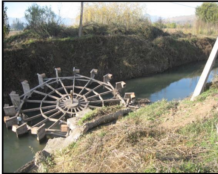
Figura 15 Rueda destruida terremoto 27F 2010
