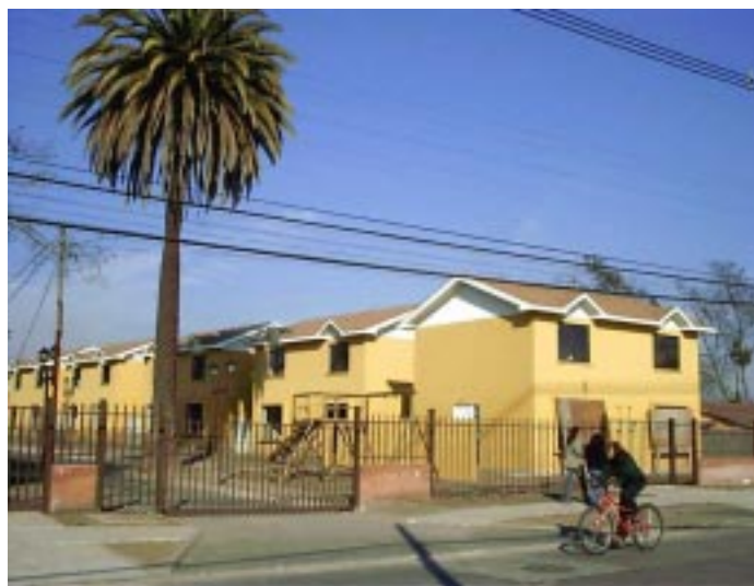
Nuevo conjunto residencial Av. Bilbao
