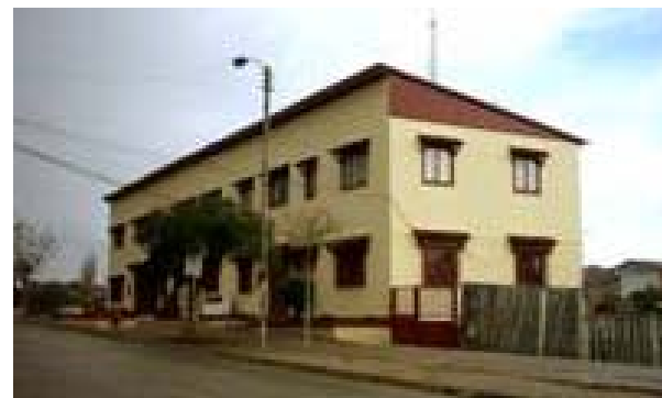
Fig. 35 Vista edificio municipal desde Av. Aníbal Pinto.
