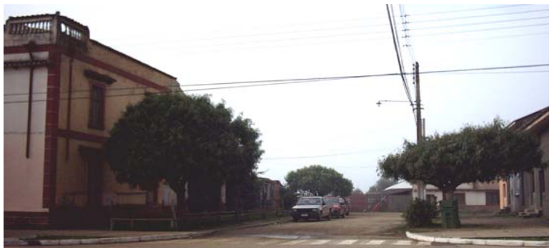
Fig. 27 Calle Bernardo O'Higgins sin continuidad.
