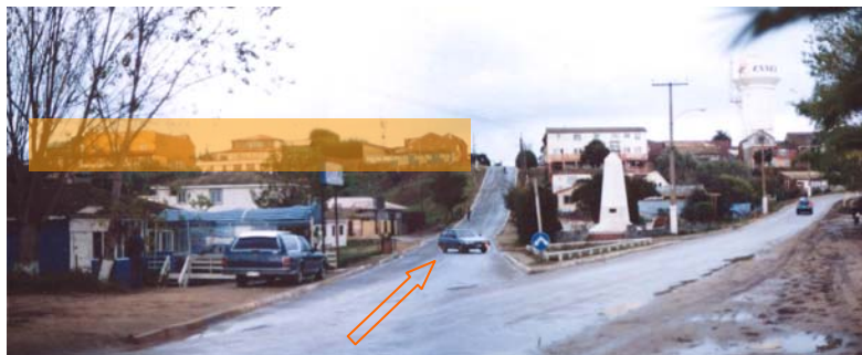
Fig. 20 Acceso por Primer Centenario.
