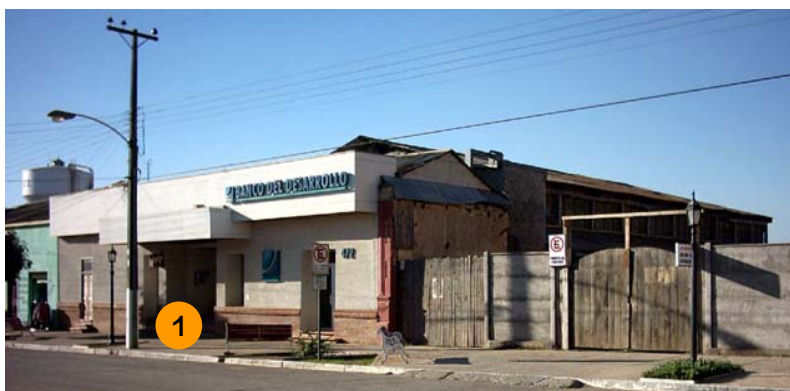
Fig. 4 Pista Municipal: Galpón con problemas estructurales.
