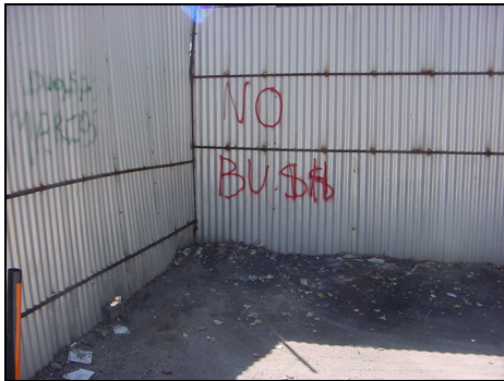
Vista noroeste cierre perimetral terreno
