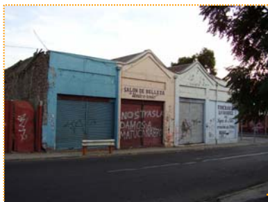
• Calle Rosas: Locales Cerrados en Deterioro
