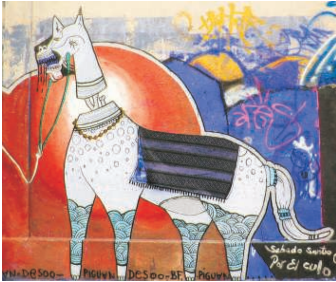
Graffiti en el muro exterior del Instituto Psiquiátrico Fachada Sur del Instituto.
