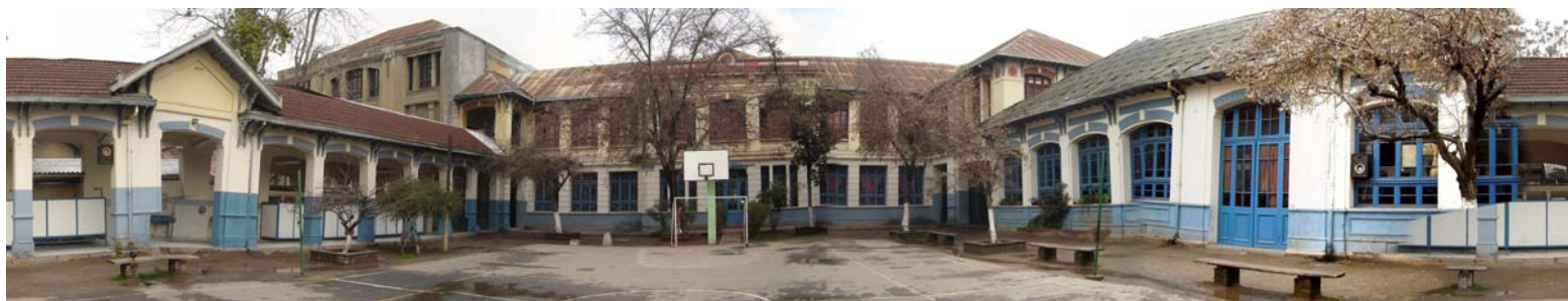
Vista de patio lateral
