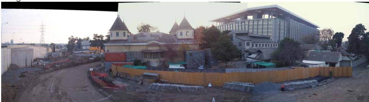
Vista desde Autopista Central
