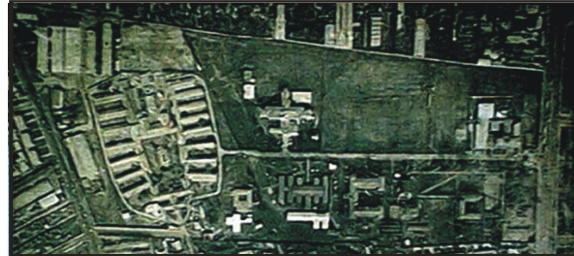
Foto aérea Hospital Barros Luco antes de la construcción del CDT (fuente SSMS)
