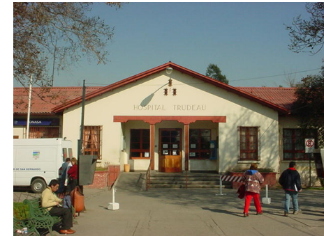
Vista acceso principal
