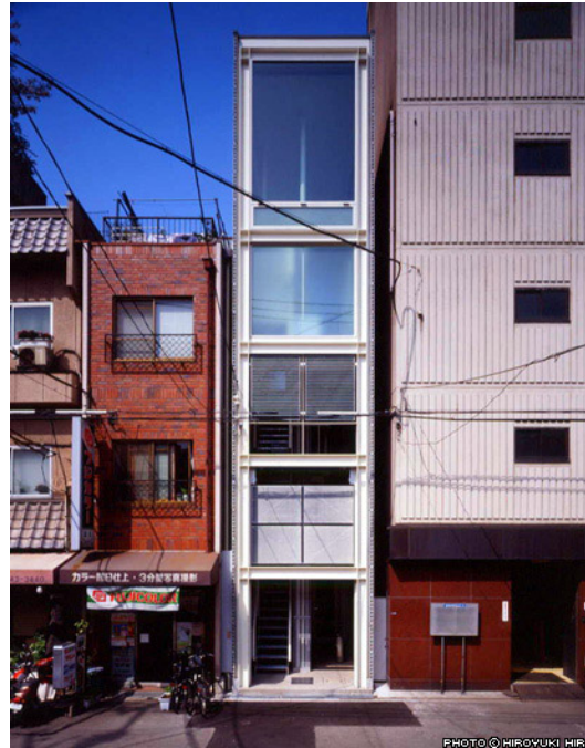
25 Vivienda en Nipponbashi, Osaka, del arquitecto Waro Kishi, 1992. Esta vivienda entre medianeros tiene solo 2,5m de ancho, y se encuentra en un terreno de 44,7m 2 . Nótese que la edificación contigua tiene condiciones similares de emplazamiento.
