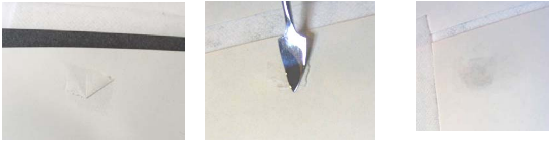
- Proceso. Detalle zona A - Desplegando papel de zona afectada - Reforzamiento realizado
