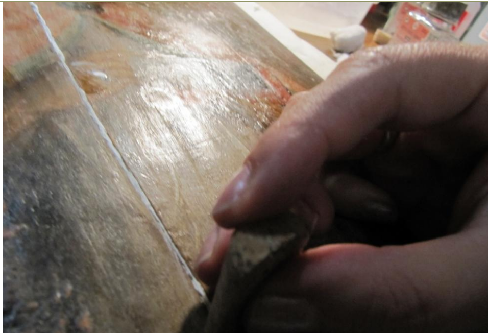
Figura 109. Se empareja el estuco mediante un corcho humedecido.
