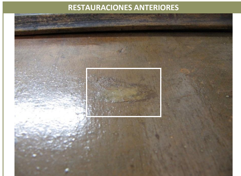
Figura 86. Irregularidad por estuco mal aplicado
