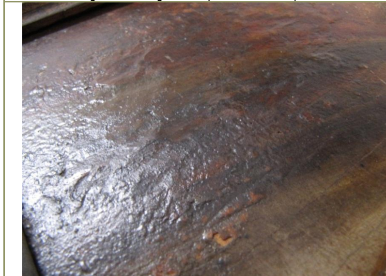
Figura 87. Desnivelado en zona inferior izquierda.
