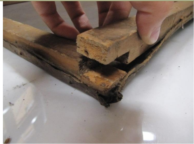
Figura 160. Vista del ensamble de una esquina.
