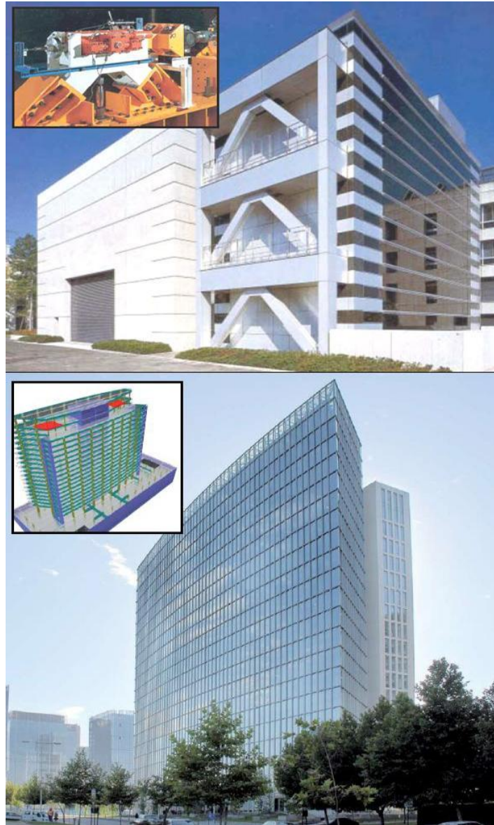
Figura 1.3: Disipadores activos y algunos ejemplos de su uso. En la figura de arriba se muestra el edificio de investigación de nuevas tecnologías en Kajima, Japón. Esta estructura posee sistemas de rigidez variable dispuestos como arrostramientos en V invertida. Se aprecia también un detalle del dispositivo de rigidez variable, [43]. En la figura de abajo en tanto, se muestra el edificio Parque Araucano en Santiago, Chile. La implementación de dos disipadores de masa semi-activos, mostrados en rojo en el esquema, tiene como función principal controlar los máximos desplazamientos y reducir los efectos de torsión en la estructura.
