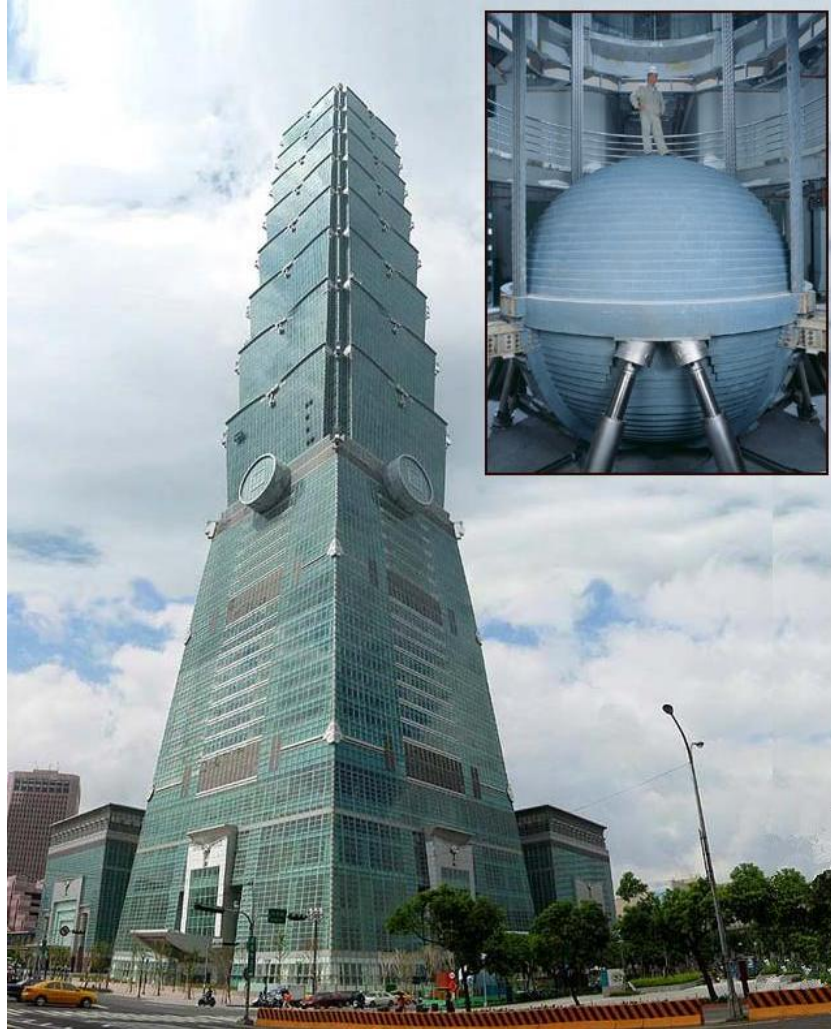
Figura 2.2: Edificio Taipei 101 en Taipei, Taiwán. Esta colosal estructura posee un DMS tipo péndulo que controla la respuesta del edificio frente a fuertes vientos, [42].
