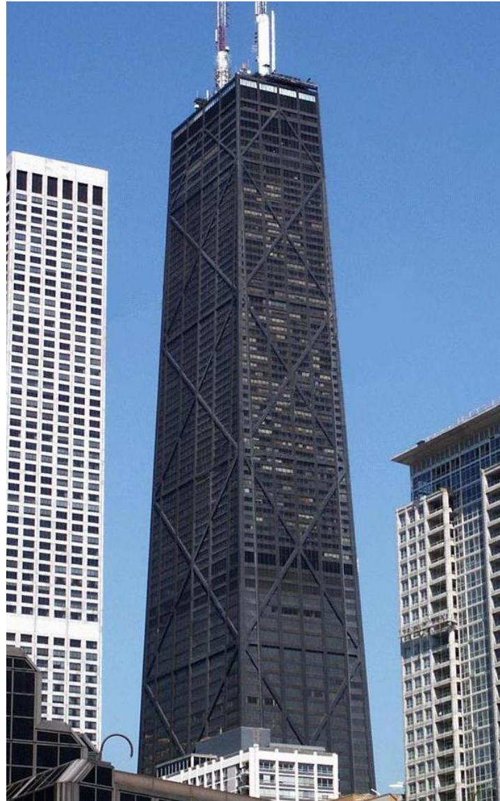
Figura 2.4: Edificio John Hancock en Chicago EE.UU. Análisis realizados posteriormente a su construcción indicaron que el edificio carecía de suficientes arrostramientos como para garantizar la comodidad de los ocupantes durante fuertes vientos. Se decidió por tanto incorporar dos DMS en el piso 58 para controlar la respuesta de la estructura.
