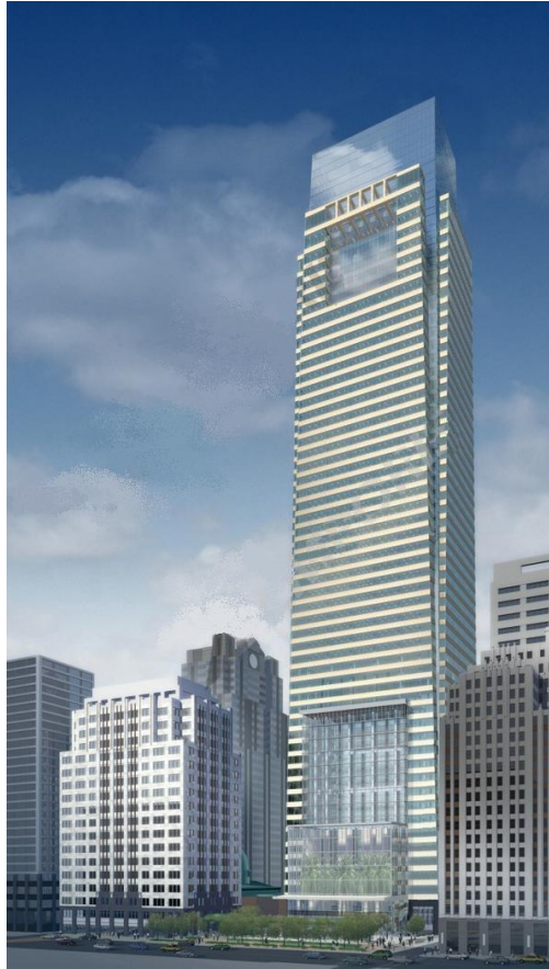
Figura 3.2: Edificio Comcast Center, Philadelphia. Esta estructura, actualmente en construcción, contará con el disipador de columna líquida sintonizada más grande del mundo. El dispositivo, de 1300 [ton] de agua, se ubicará en la cima de la estructura y tendrá como función reducir la respuesta de la estructura frente a la acción del viento, [42].
