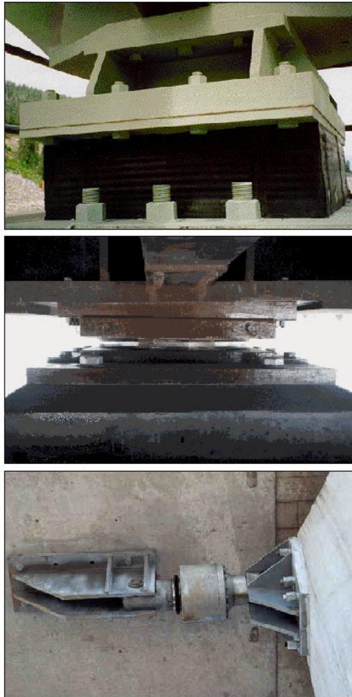
Figura 1.2: Ejemplos de utilización de dispositivos de protección sísmica en puentes. La figura de arriba muestra un aislador sísmico de goma con núcleo de plomo usado como apoyo para la superestructura. En la figura central se muestra un aislador de base tipo péndulo de fricción utilizado con el mismo objetivo. En la figura de abajo en tanto, se aprecia un amortiguador fluido dispuesto entre la cepa y la superestructura del puente, con el objeto de controlar los desplazamientos de los tramos, [45].
