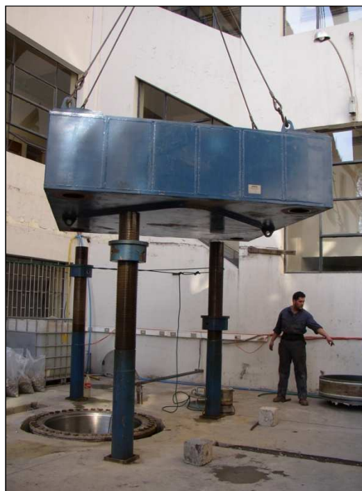
A1.24 - Montaje de cabezal superior
