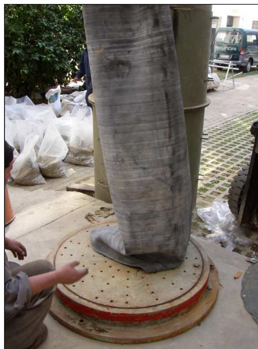
A1.4 - Instalación de primera membrana de caucho
