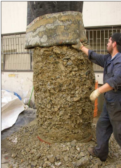
A1.31 - Fase final del retiro de la membrana
