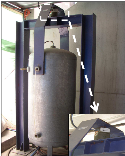
Figura 4.14 Estanque de agua de 500 l (IDIEM).
