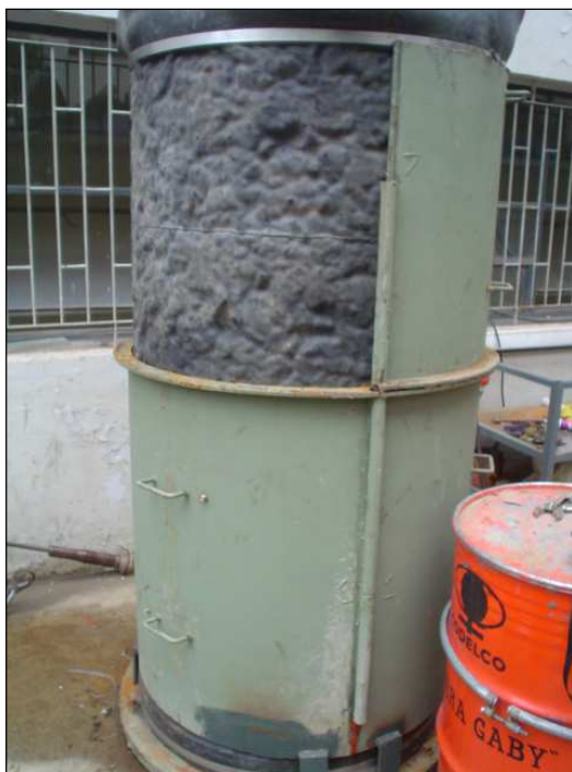
A1.9 - Retiro de molde metálico
