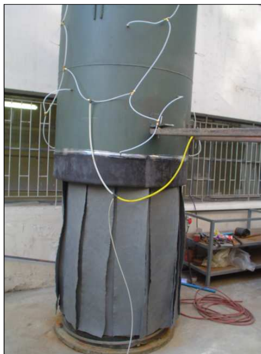
A1.12 - Instalación de segunda membrana
