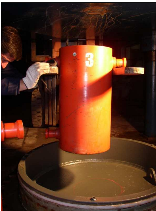
A1.21 - Instalación de cilindros hidráulicos
