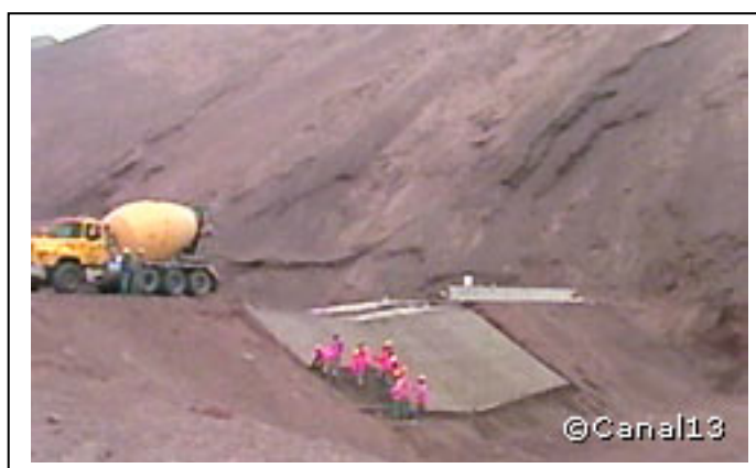
Figura N° 8: Obras de Mitigación
