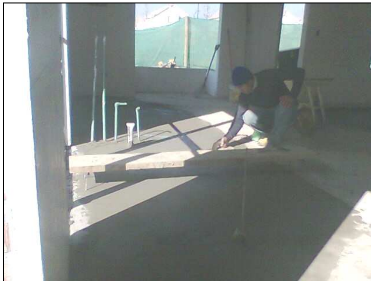
Figura 9: Fotografía Nivelación de Losas.
