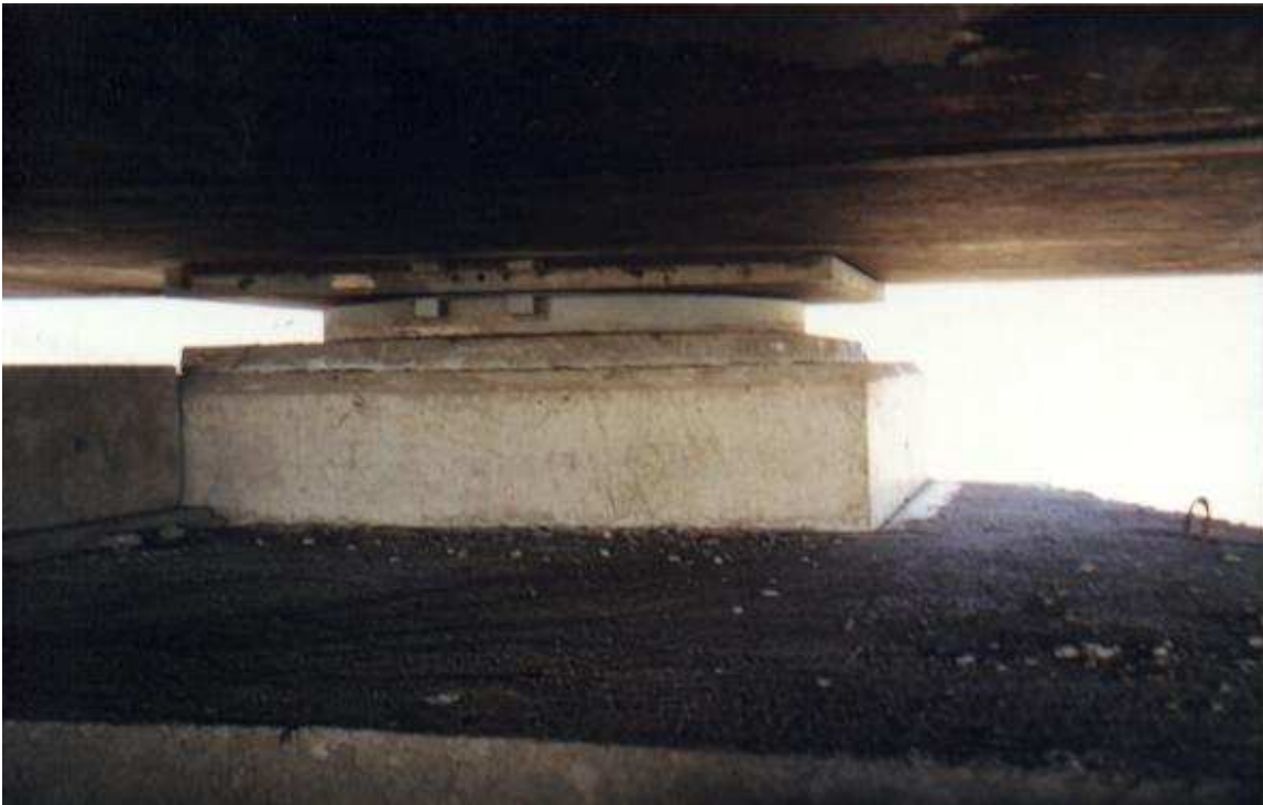
Figura 2.13: Fotografía de un apoyo tipo del Puente Amolanas
