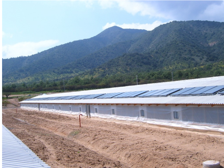
Figura 3.20: Galpón con los colectores solares ubicados en el techo, Fuente [15]
