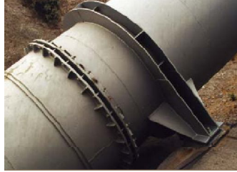
Figura 5.14 Apoyo de tubería central Los Quilos Seguido por junta de expansión
