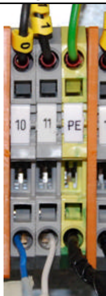
Figura A. 6. Proceso de montaje de equipos electronicos
