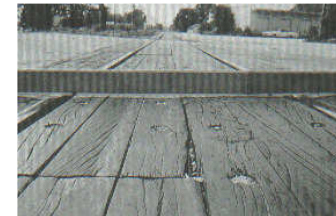
Figura A14-a. Cruce de vía férrea de baja severidad.
