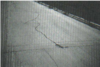
Figura C23-b. Losa dividida de severidad media.
