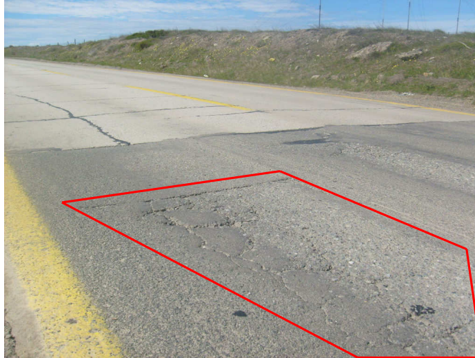
Ruta 9, Km 30,287: Inicio tramo pavimento asfáltico. Grieta tipo piel de cocodrilo de severidad media.
