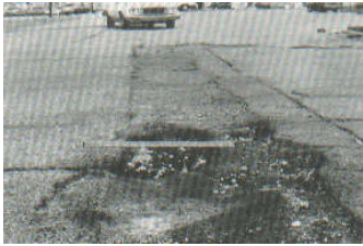
Figura A11-c. Parcheo y acometidas de servicios públicos de alta severidad.
