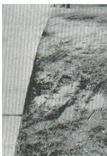
Figura C27-b. Desnivel carril / berma de severidad media.
