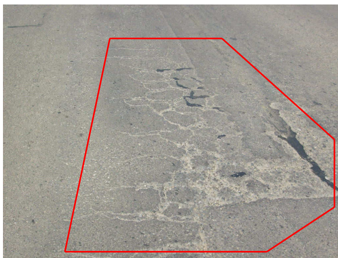
Camino Gobernador Phillipi Km 11. Grieta tipo piel de cocodrilo de severidad alta. Desprendimiento de agregados de severidad alta.
