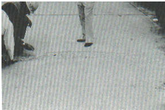
Figura C24-b. Grieta de durabilidad de severidad media.
