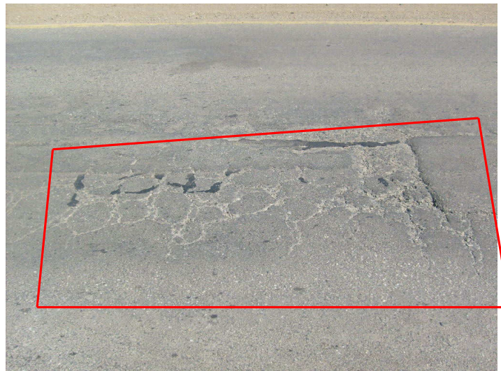
Bifurcación Ruta 9 – Camino Gobernador Phillipi (Km 0): Grieta tipo piel de cocodrilo de alta severidad.
