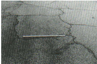
Figura A3-b. Grietas en bloque de severidad media.
