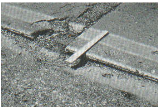
Figura C27-a. Desnivel carril / berma de baja severidad.
