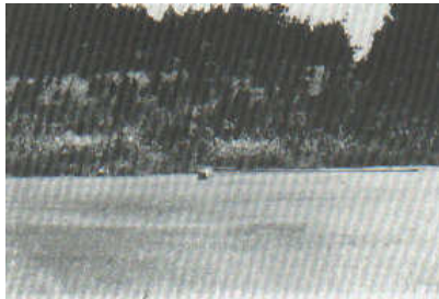
Figura A18. Ejemplo de hinchamiento. El nivel de severidad se basa en el criterio de la calidad de tránsito.
