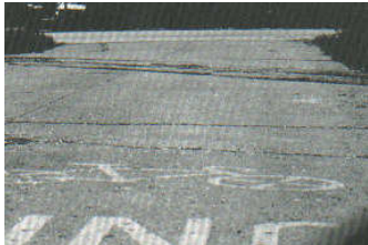
Figura C35-b. Cruce de vía férrea de severidad media.
