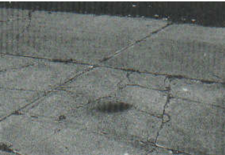
Figura C23-c. Losa dividida de alta severidad.
