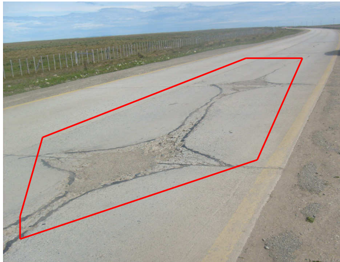
Ruta 9, Km 28: Descascaramiento de esquina de alta severidad.
