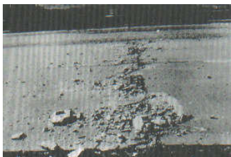
Figura C21-b. Blowup / Buckling de baja severidad.
