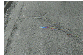
Figura A17-b. Grieta parabólica (slippage) de severidad media.
