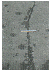
Figura C28-b. Grietas lineales de severidad media en losa de concreto reforzado.
