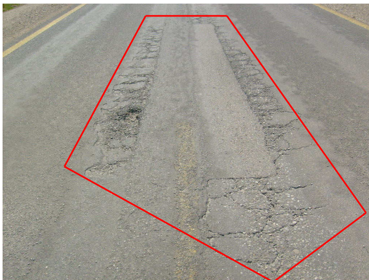
Camino Gobernador Phillipi Km 7. Grieta tipo piel de cocodrilo de severidad alta. Desprendimiento de agregados de severidad alta. Zona de BAcheo
