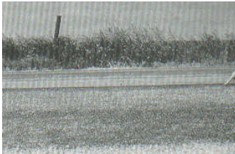
Figura A5-a. Corrugación de baja severidad.
