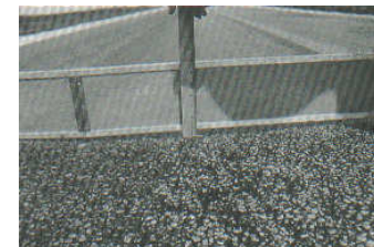
Figura A15-b. Ahuellamiento de severidad media.
