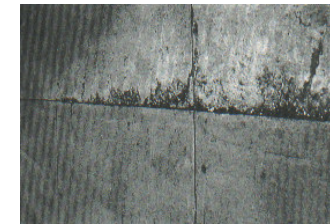
Figura C39-b. Descascaramiento de junta de severidad media.
