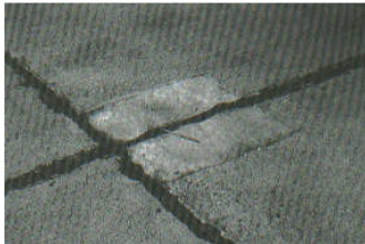
Figura C30-a. Parche pequeño de baja severidad.
