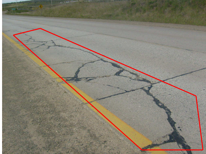
Ruta 9, Km 18: Losa dividida de alta severidad con sello de grietas en buen estado.
