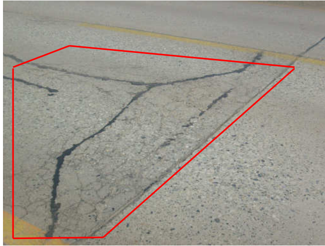
Ruta 9 , Km 15: Losa dividida de baja severidad con sello de grietas en buen estado. Presencia de Mapa de grietas de baja severidad
