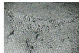
Figura C38-c. Descascamiento de esquina de alta severidad.
