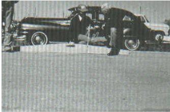
Figura A6-a. Depresión de baja severidad.
