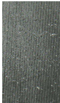
Figura A2-c. Exudación de alta severidad.
