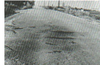
Figura A16-b. Desplazamiento de severidad media.
