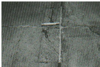
Figura C30-c. Parche pequeño de alta severidad.
