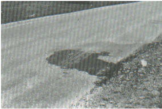
Figura A11-b. Parcheo y acometidas de servicios públicos de severidad media.
