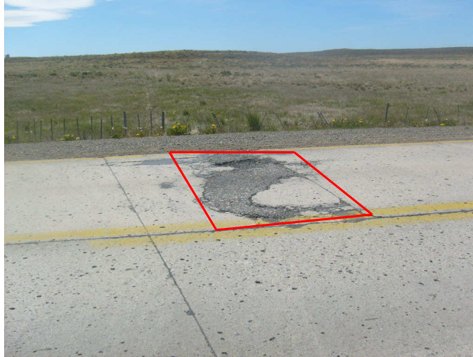
Ruta 9, Km 50: Parche grande en mal estado. Nivel de severidad media.
