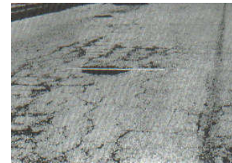
Figura A13-b. Hueco de severidad media.
