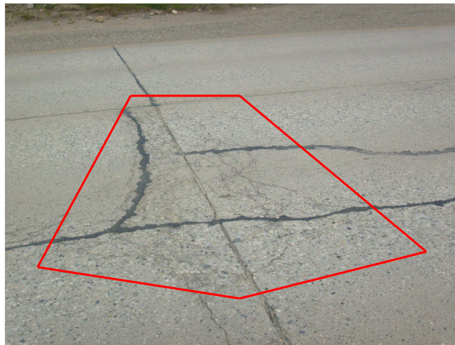
Ruta 9, Km 17: Losa dividida de baja severidad con sello de grietas en buen estado. Presencia de Mapa de grietas de baja severidad.
