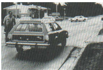
Figura C21-c. Blowup / Buckling de baja severidad.
