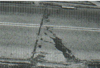
Figura C34-b. Punzonamiento de severidad media.
