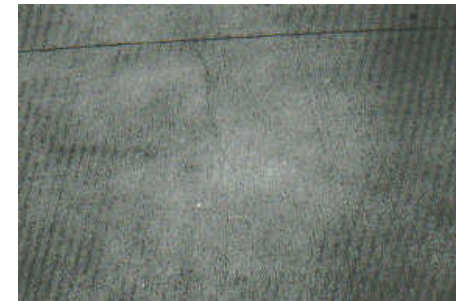
Figura C37. Grietas de contracción.
