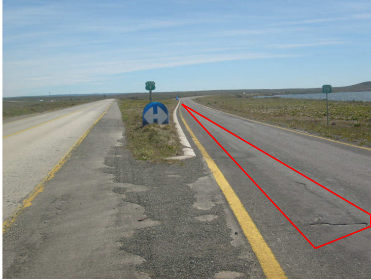
Bifurcación Ruta 9 – Camino Gobernador Phillipi (Km 0): Desprendimiento de agregados de baja severidad. Grietas longitudinales y transversales de baja severidad.
