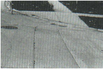
Figura C29-a. Parcho grande y acometidas de servicios públicos de baja severidad.
