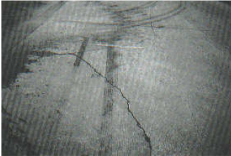
Figura C23-a. Losa dividida de baja severidad.
