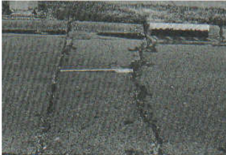
Figura C34-a. Punzonamiento de baja severidad.
