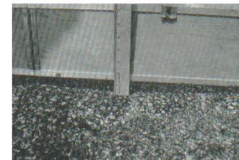
Figura A15-c. Ahuellamiento de alta severidad.
