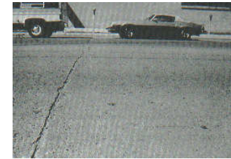
Figura C39-a. Descascaramiento de junta de baja severidad.
