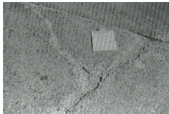
Figura C22-c. Grieta de esquina de alta severidad.
