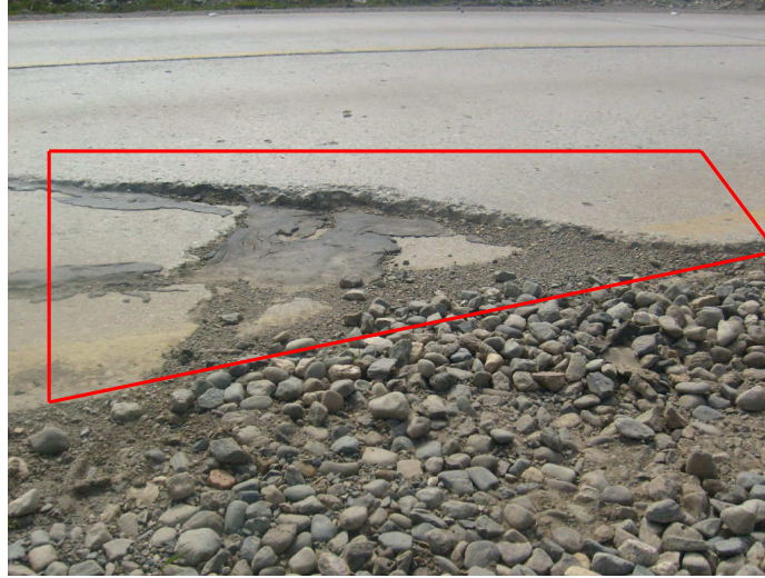
Ruta 9, Km 20: Losa dividida de alta severidad.
