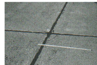
Figura C38-a. Descascamiento de esquina de baja severidad.
