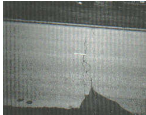
Figura A10-b. Grietas longitudinales y transversales (No PCC) de severidad media.
