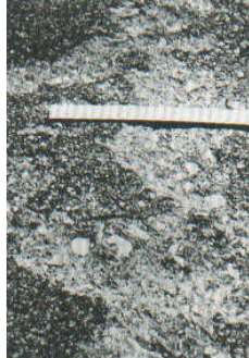
Figura C36-b. Desconchamiento / Mapa de grietas / Craquelado de severidad media.
