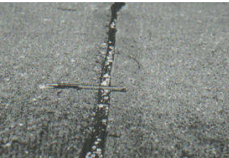
Figura C26-c. Daño del sello de junta de alta severidad.
