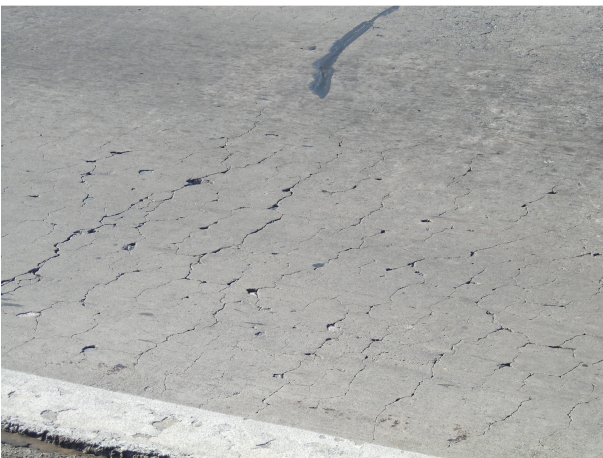
DETERIORO SUPERFICIAL HORMIGÓN
