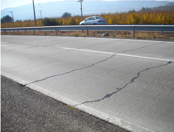
GRITA EN LOS TERCIOS DE LA LOSA
