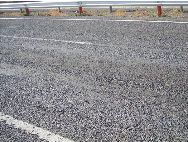
DOBLE TRATAMIENTO SUPERFICIAL
