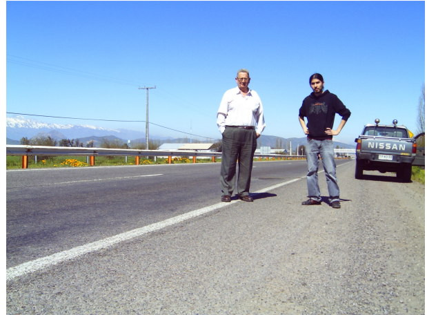
DOBLE TRATAMIENTO SUPERFICIAL
