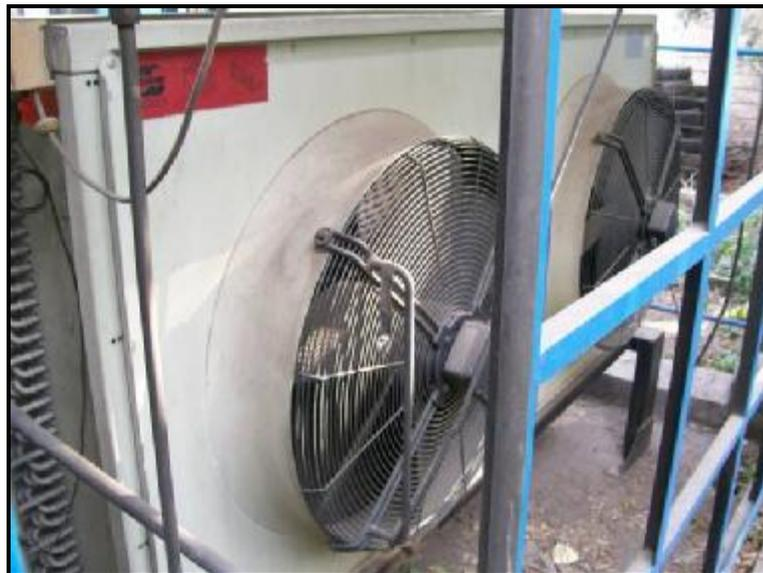
**Figura 6.4** Condensador
