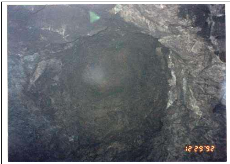
Foto N°4: Oquedad en la pared oeste del slot S1-S2, del nivel 3104, en brecha de biotita con cizalle N30°W/50°W, de 3m de diámetro y 5 m de profundidad.
