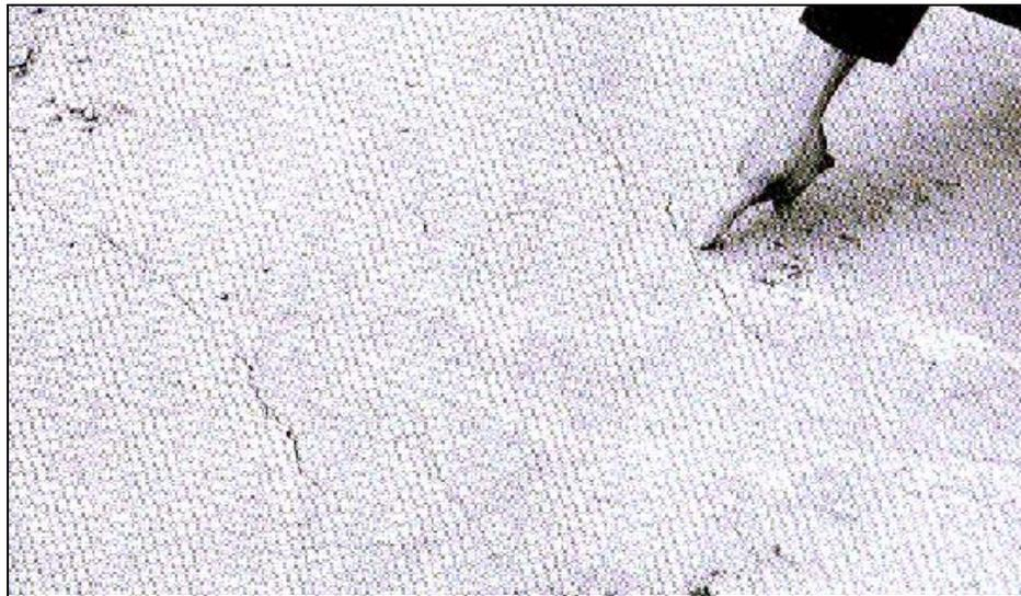
Figura N°2.10 Las fisuras de retracción plástica se producen a causa de una rápida pérdida de agua de mezclado cuando el hormigón está en estado plástico.
